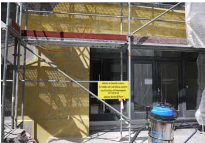
Abbruch des nachträglich angefügten Vordaches (Eingang Bestattung) Anpassung des Verputzes am Sturz des Eingangs zur Bestattung
