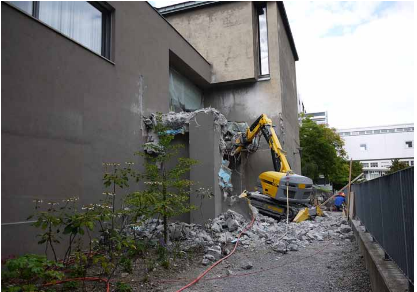
Abbruch des nachträglich angefügten Vordaches (Eingang Bestattung) Anpassung des Verputzes am Sturz des Eingangs zur Bestattung
